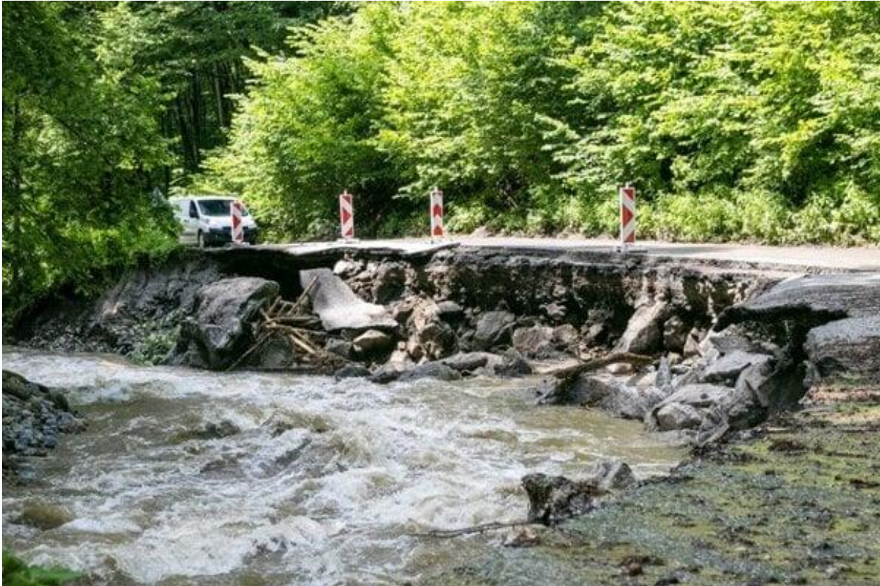
Obr. 6.2. Dôsledky extrémnych zrážok. V júni 2020 intenzívna búrka na Gemeri strhla kus cesty č. II/531 na úseku Muráň – Predná Hora (Zdroj: BBSK, 2020)
